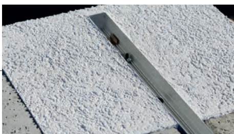
Bei Verputz-Variante den Abrieb bündig zum Einlegeprofil auftragen.
