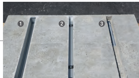
Situation nach dem Ausschalen 1) 6050 Sichtbeton Einbau · 2) 3030 Sichtbeton Einbau · 3) 3030 Verputz Einbau
