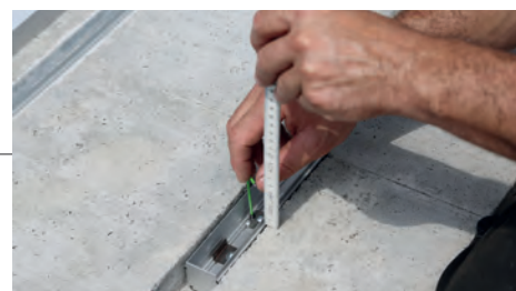
Bei Verputz-Variante die Höhe des Einlegeprofils für entsprechende Verputzschichtdicke justieren
