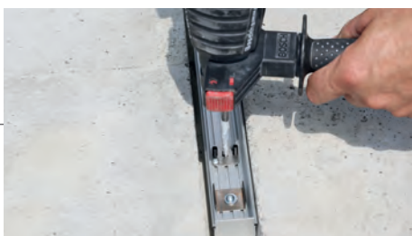
Bei Verputz-Variante die Montage des Einlegeprofils vorbereiten (Befestigungslöcher bohren)
